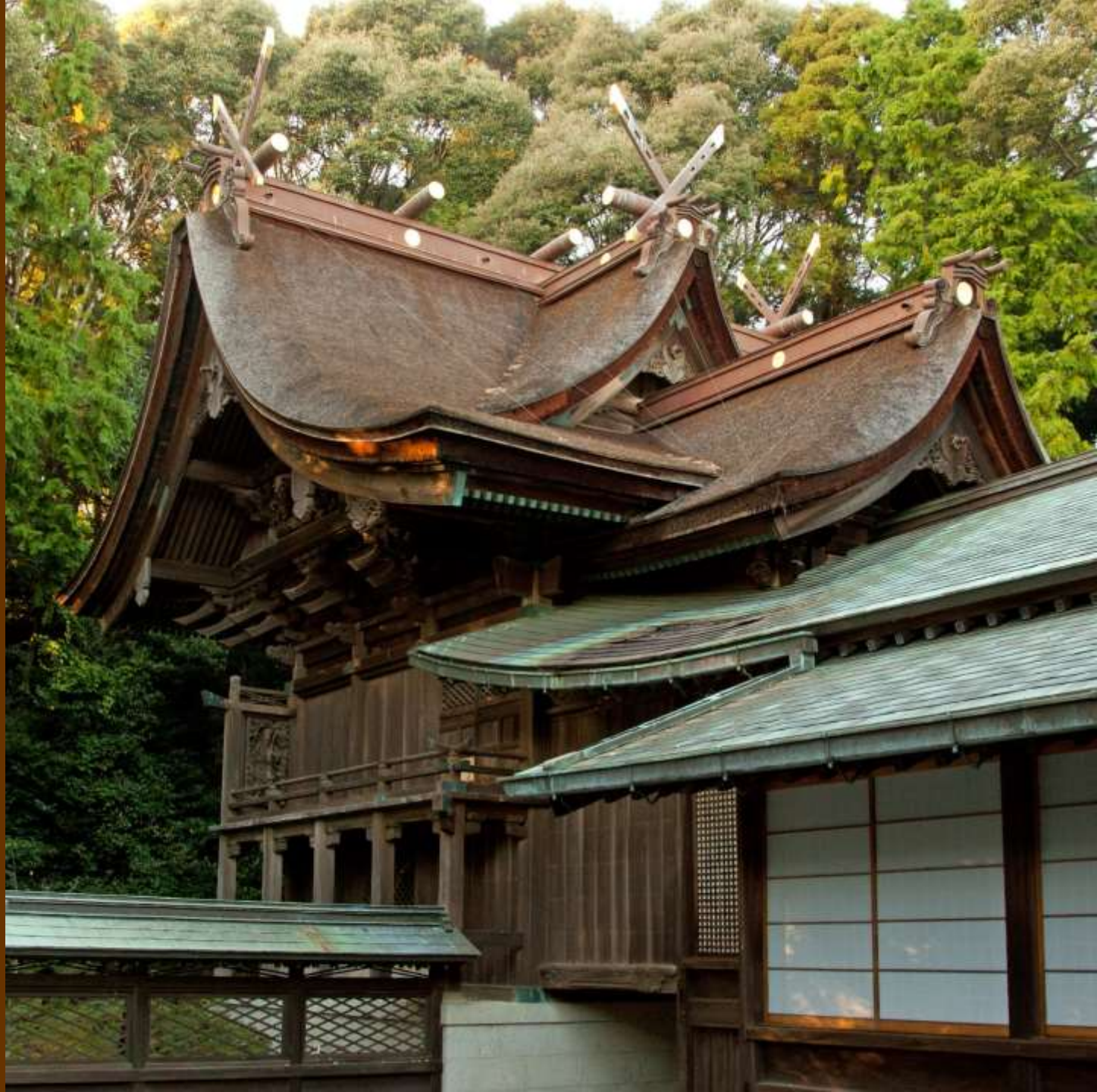
長尾八幡宮 本殿 山口県周防大島町 平成21年施工
