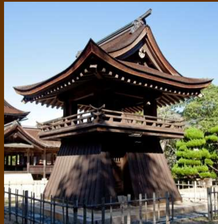
正八幡宮 鐘楼 平成21年施工
